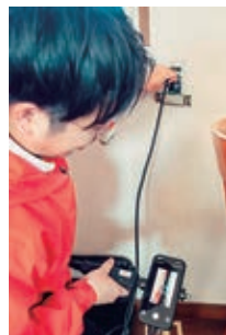
住宅診断の様子
